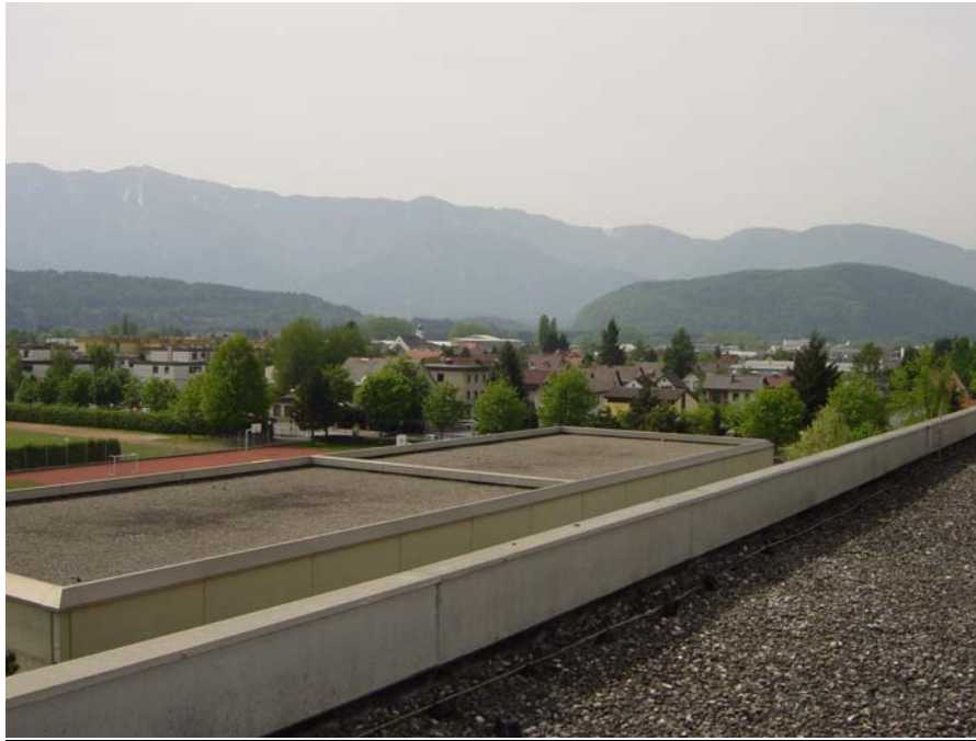
Abbildung 6-1: Flachdachsanierung der HTL-Villach [Werner, 2003]
